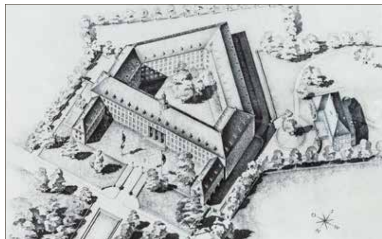
Budynek Urzędu Wojewódzkiego przy obecnej ulicy Andersa to ciekawy architektonicznie obiekt; zbudowano go na planie pięciokąta.
