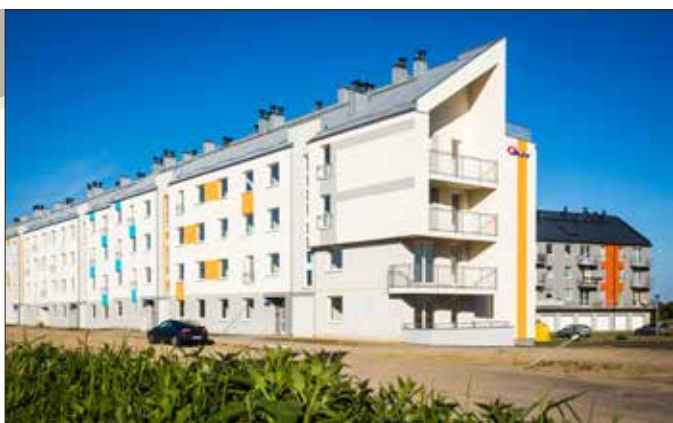
Orlex Danuta Gębarowska Budynki przy ulicy Halera
