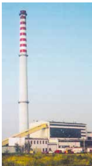
Widok na kotłownię FUB.
