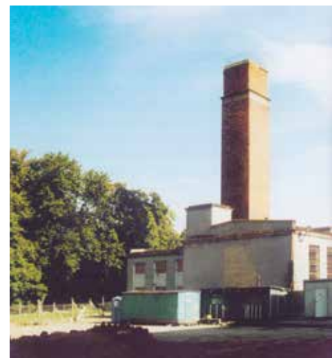
Dawna kotłownia centralna przy ul. Mickiewicza 24.
