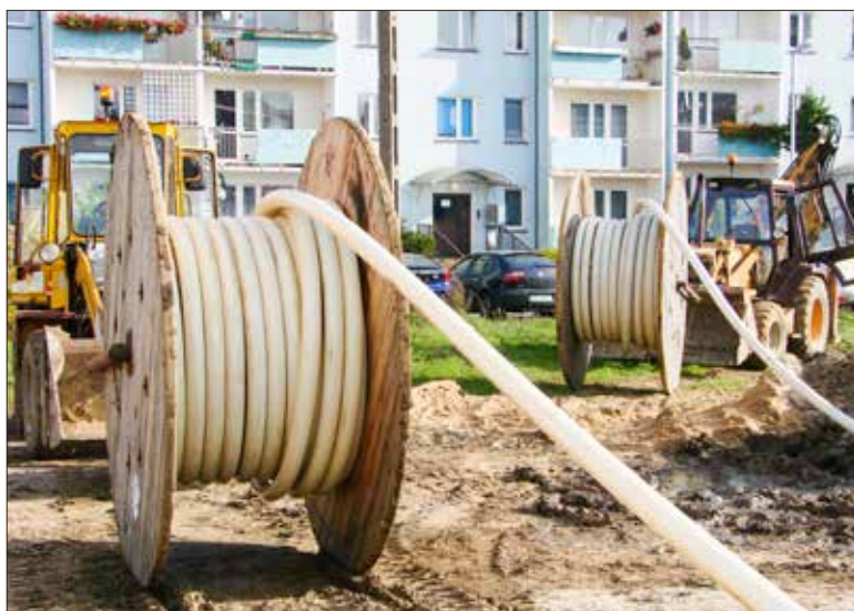
Po użyciu giętką rurę można nawinąć na bęben i zastosować kolejny raz w innym miejscu.
