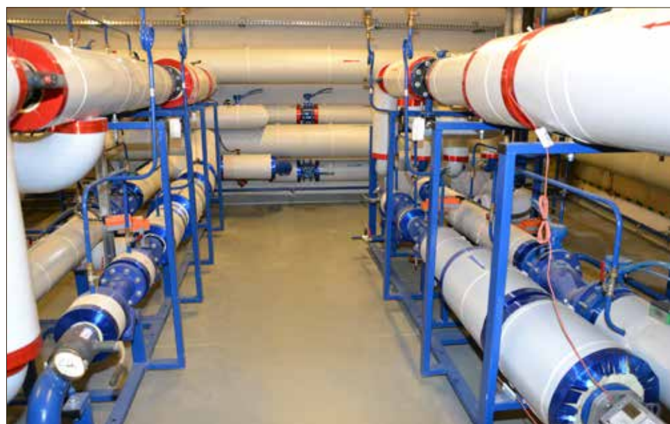
Po prawej najważniejszy i zarazem największy moduł węzła cieplnego: tzw. technologii basenowej. Stąd płynie ciepło potrzebne do ogrzania wody we wszystkich basenach czy jacuzzi.
