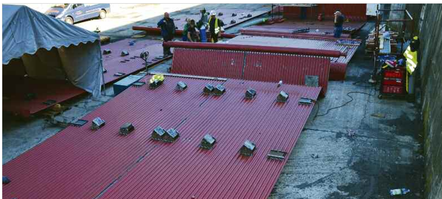
Ten widok daje pojęcie, jak wielkim urządzeniem jest kocioł WR 25 – większość elementów, zastosowanych podczas modernizacji, była przygotowywana na zewnątrz ciepłowni...
