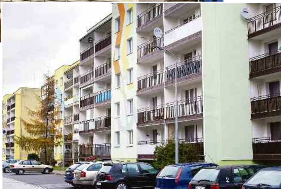
Wiele już istniejących budynków, jak przy ul. Bosmańskiej, zyskuje ciepłą wodę, ogrzewaną za pośrednictwem ciepła systemowego. Do tej pory odpowiadały za to indywidualne piecyki gazowe.
