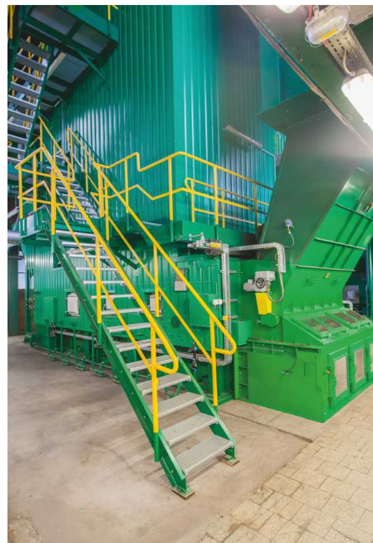
Ostatni ze zmodernizowanych kotłów nie należy do największych, wykorzystywanych w naszych ciepłowniach, ale i tak nie mieści się w kadrze.
